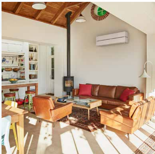
Bild: Mitsubishi Electric LES
