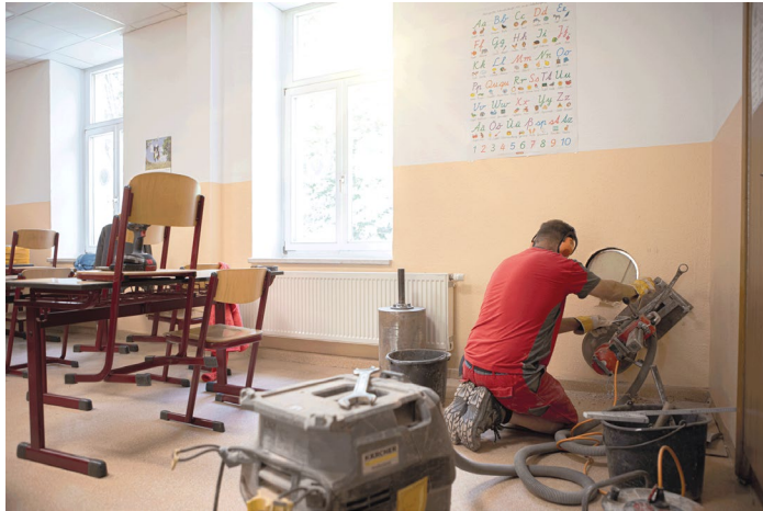
Für die Nachrüstung dezentraler Lüftungsgeräte wurden in der Grundschule Eibenstock je Raum zwei Kernlochbohrungen (für Zu- und Abluft) durch die Außenwand geführt. Bild: VALLOX GmbH
