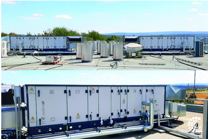
Zentrale Lüftungsgeräte eignen sich besonders für Neubauten oder bei größeren Umbauten. Sie werden häufig auf dem Dach des Gebäudes oder in einem Technikraum installiert. Bild: Systemair
