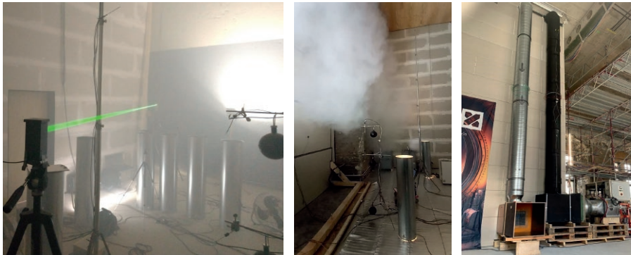
Bild 2: Messaufbau im Reallabor: I/O-Scan (Luftwechsel in Aufenthaltszone), Behaglichkeitsmessplatz, vertikale Temperaturverteilung, mobile Lüftungsanlage, mobile Fußbodenheizung, Strömungsvisualisierung
