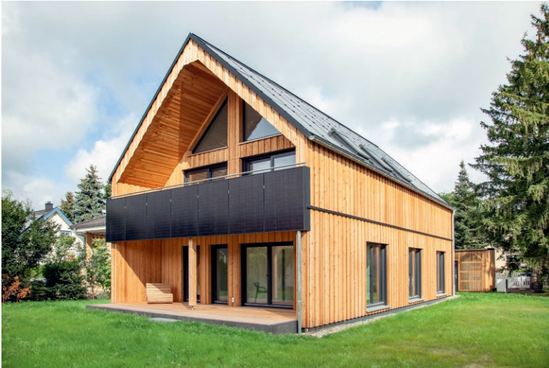
Abbildung 1: FlexEhome: Ansicht des fertiggestellten Gebäudes (Foto: Anja Bäcker)
